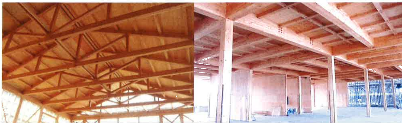
流通製材と住宅用プレカットによる 12m スパン山型トラス
